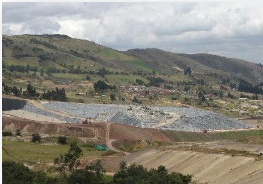
Foto 3.9: Relleno Sanitario de Doña Juana, con la reconfiguración del terreno en la forma de terracitas de relleno con la impermeabilización de los taludes con geotextil y la modificación del drenaje. Foto Revista Semana.
